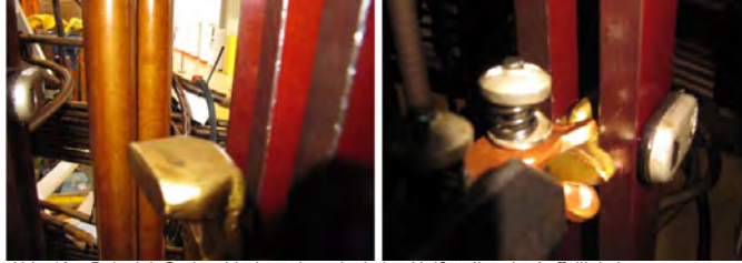
Abb. 10a: Beispiel: Grobwählerkontakt, zeigt keine Heißstelle oder Auffälligkeiten
